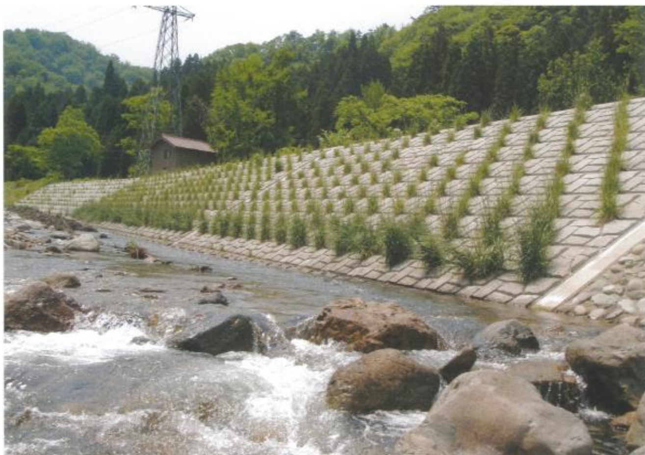
石川県大聖寺川（施工完成1年）
