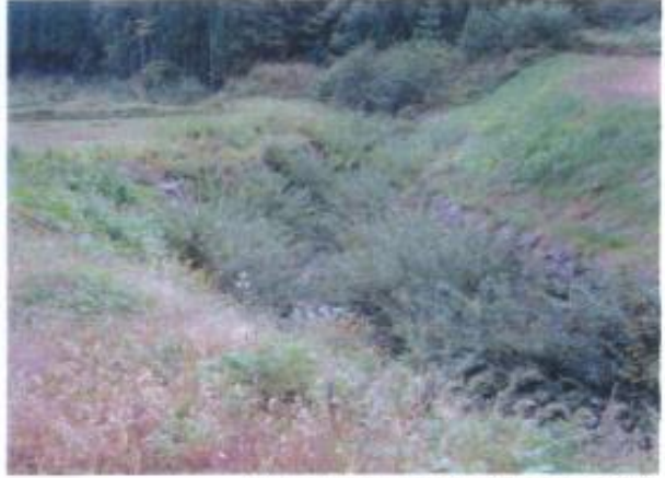
岐阜県稲越川最上流（施工後4年）
