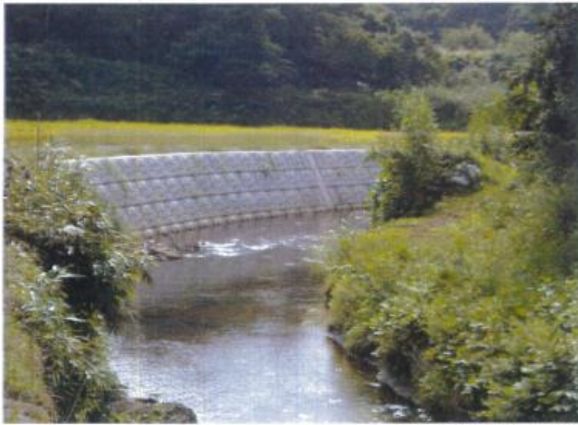
新潟県百川（施工直後）
