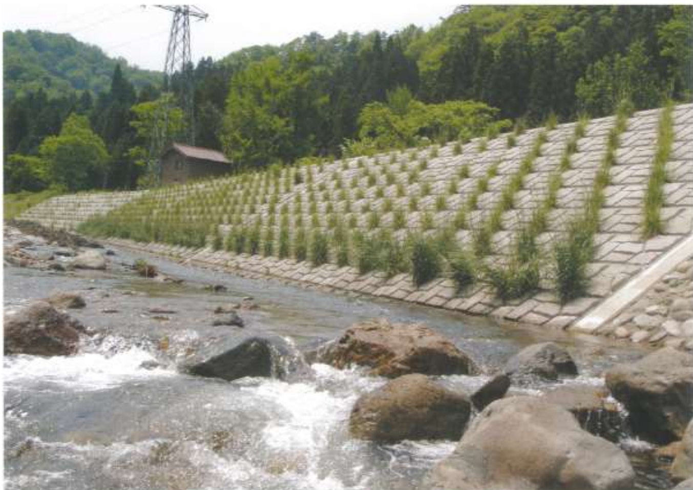
石川県大聖寺川（施工完成1年）
