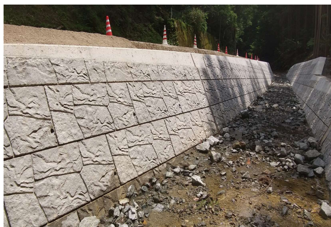
● 松阪建設事務所発注：合ヶ野線松阪線道路改良工事
