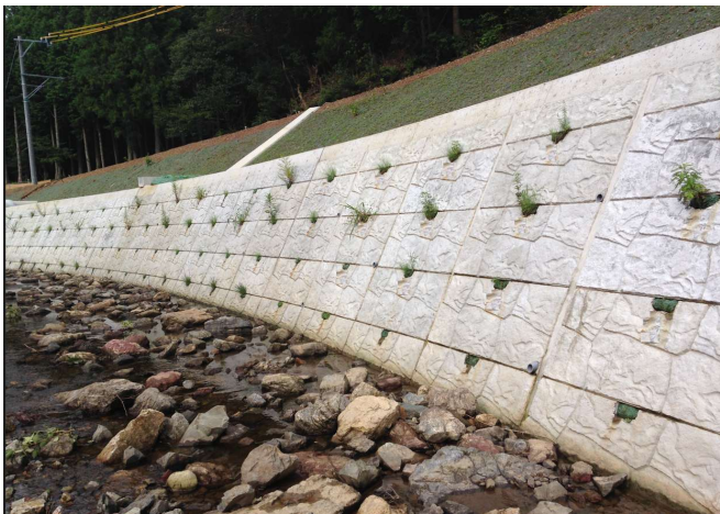
● 伊勢建設事務所発注：藤川(右岸)河川災害復旧工事
