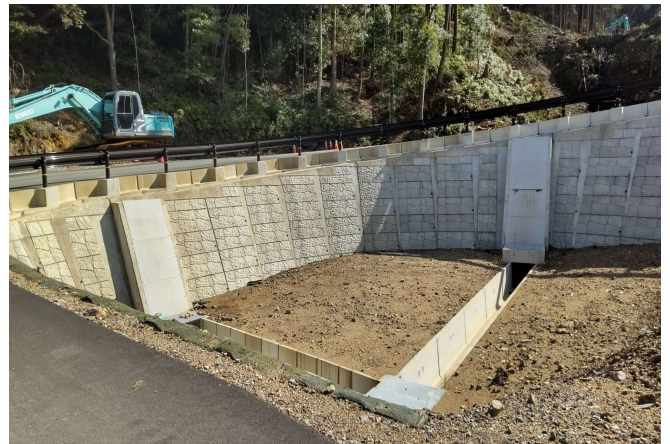
● 志摩建設事務所発注：鳥羽河内ダム付替道路工事
