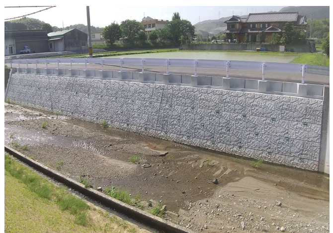
● 桑名建設事務所発注：落合川(左岸)災害復旧工事
