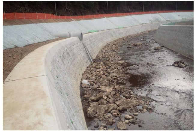
● 伊勢建設事務所発注：横輪川河川災害復旧工事
