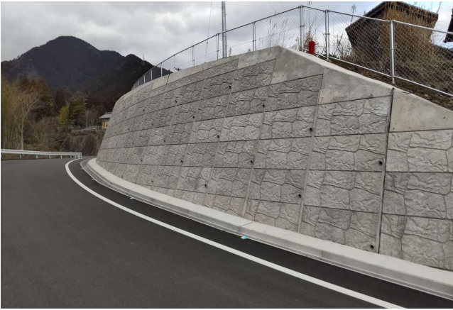
● 鈴鹿建設事務所発注：一般国道25号道路改良工事
