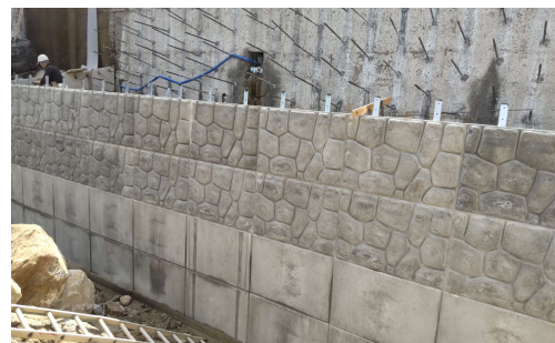
擬石・滑面での施工が可能
