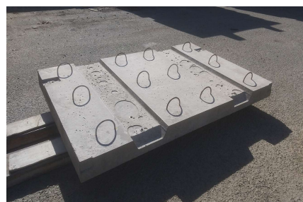
φ6mmのフック筋を設置
