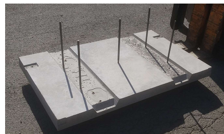
D13-L350の直筋をパネルに設置
