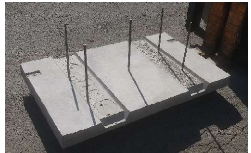
D13-L350の直筋をパネルに設置
