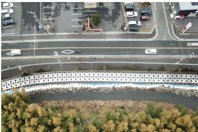
伊東大川 2t 型・根固工／静岡県 熱海土木事務所
