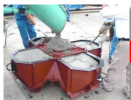
①打設～締固め
