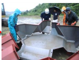
②側枠の取付(1)
