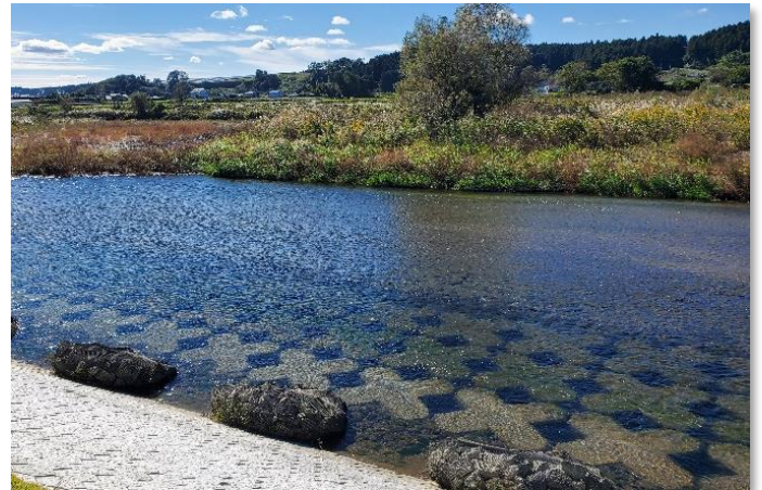
箒川 4t 型・根固工／栃木県 大田原土木事務所
