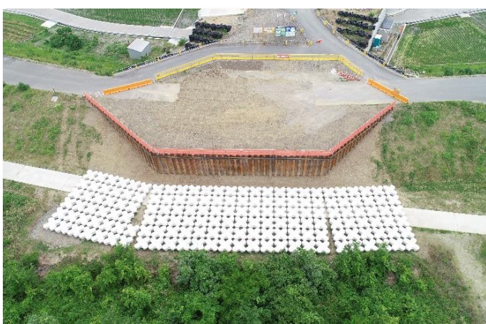
物部川 2t 型・橋脚根固工／国交省 土佐国道事務所
