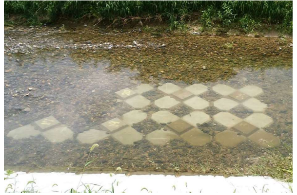
【足見川2 t 突型・根固工／三重県 四日市建設事務所】
