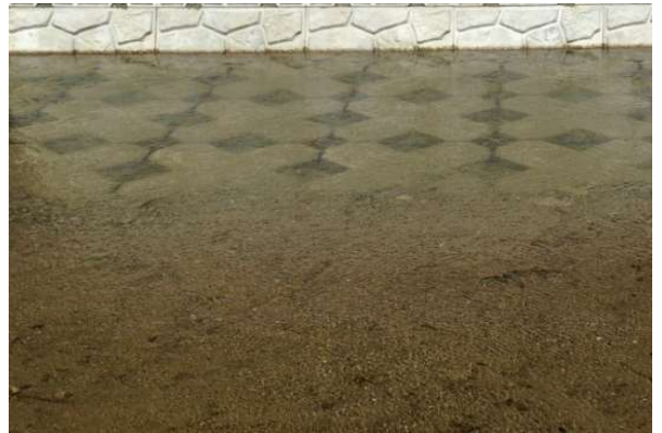
【多志田川1t型・根固工／三重県 桑名建設事務所】
