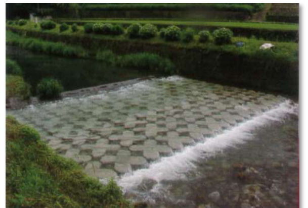
【西山川1t型・床固工／高知県 中央西土木・越智(事)】
