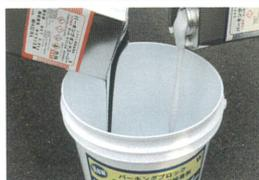
No2 パーキングボンドスーパーを練り混ぜます。(P11■パーキングボンドスーパー練り混ぜ、塗布参照)
