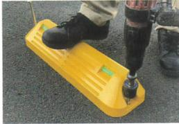
No.3 本体を押さえつけながらプレーカーでアンカーピンを叩き込みます。
