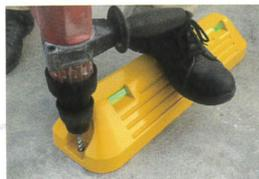
No.2 設置位置を測量し、設置面を掃除後、本体を定位位置に置き押しつけながらピン位置にドリルで穴あけをします。
