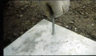
No.3 NSP-BASEにアンカーピンを打込み、インサート保護キャップを取り外した後に付属のボルトを捻じ込みます。(85H用、100H用、120H用あり)
