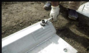
No.5 樹脂ワッシャ(黒)から突出したボルトに平ワッシャ及びナットを取付け左右交互に締付けます。
