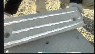
No.4 NSP-BASEとパーキングブロックの間に接着剤を塗布した後、パーキングブロック貫通孔にボルトを通し付属の樹脂ワッシャ(黒)を爪に嵌めさせます。
