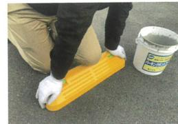
No4 本体を定位位置に置き体重をかけて圧着し設置完了。
