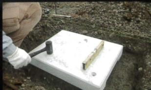
No.1 NSP-BASE設置位置を根切り・掘削・転圧しドライモルタルなどを利用してレベル調整します。
