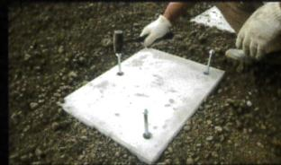
No.2 NSP-BASEにアンカーピンを打ち込みます。
