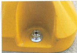
No.3 オールアンカーの芯ピンを取り除きソケットを打ち込みます。
