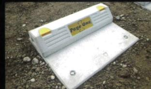
No.6 反射部が正面になるようゴムハンマーなどでキャップを取付け完成。
