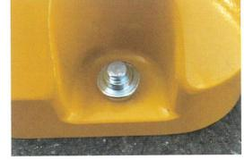
No.5 アンカーピンはぐらつきのない様に所定位置まで完全に打ち込んで設置完了。
