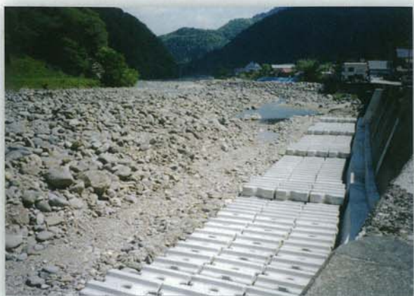
岐阜県 長良川 八幡建設事務所 6t
